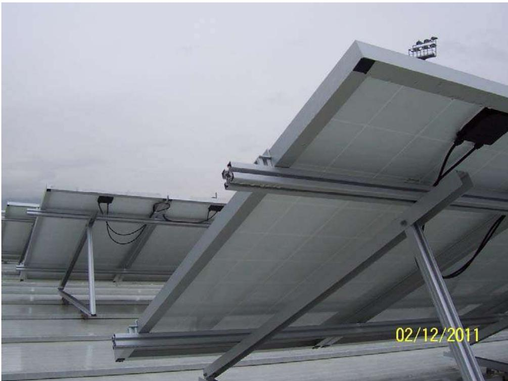
Estructura para colocación de módulos solares
